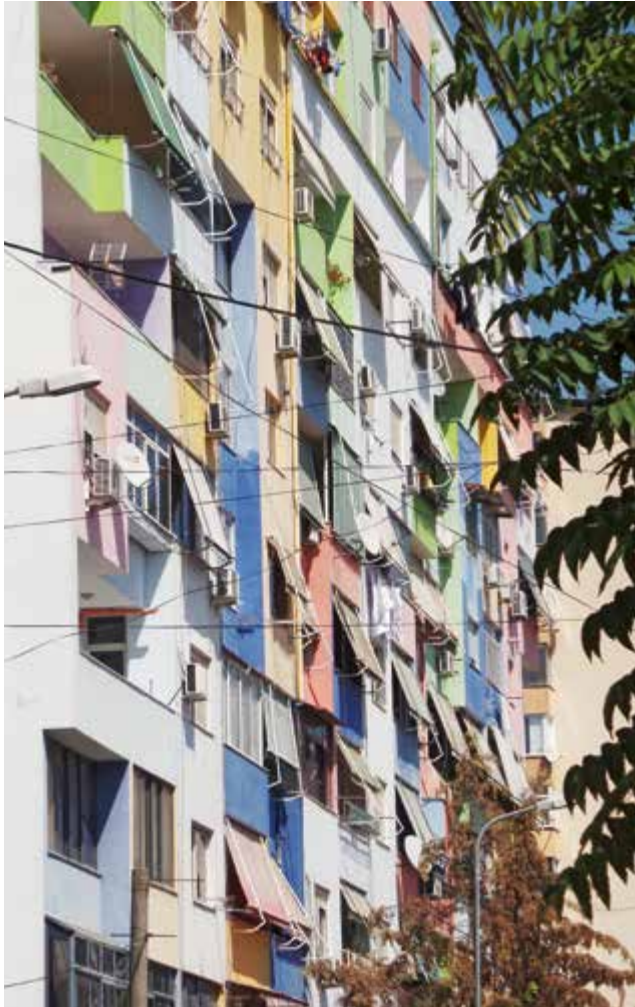
Die Farbgestaltung an diesem Wohnblock markiert vermutlich die Besitzverhältnisse.
