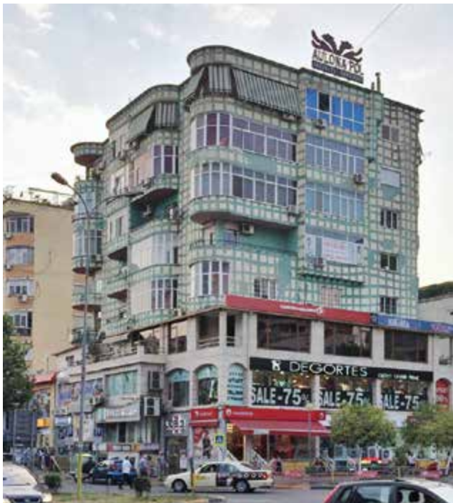
Die Farben scheinen manchmal die Gebäudevolumen aufzulösen.
