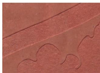
Die Außenwand des Gebäudes 168 Upper Street besteht aus eingefärbtem Ortbeton. Das Oberflächenrelief in den Wohnungen wurde mit einer in die Schalung eingelegten Matritze erzeugt. Architekten: Groupwork + Amin Taha
